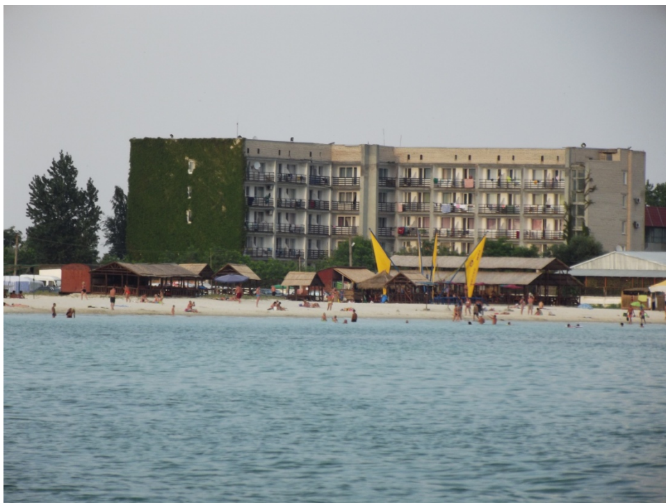
Фото 26. Строения пос. Лазурное.
